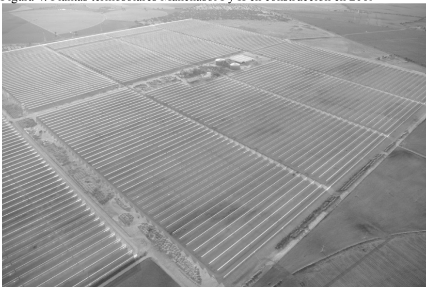
Figura 4: Plantas termosolares Manchazol I y II en construcción en 2009
