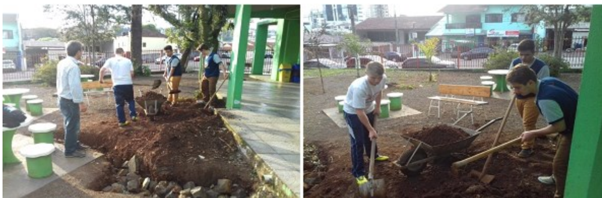
Figura 6 – Estudantes construindo o dreno no terreno ou espaço da Escola
