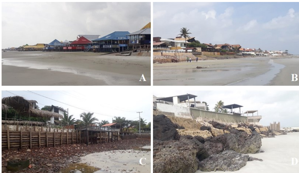
Figura 7 – Construções inadequadas nas praias do Atalaia (A, B) e Farol Velho (C, D)
